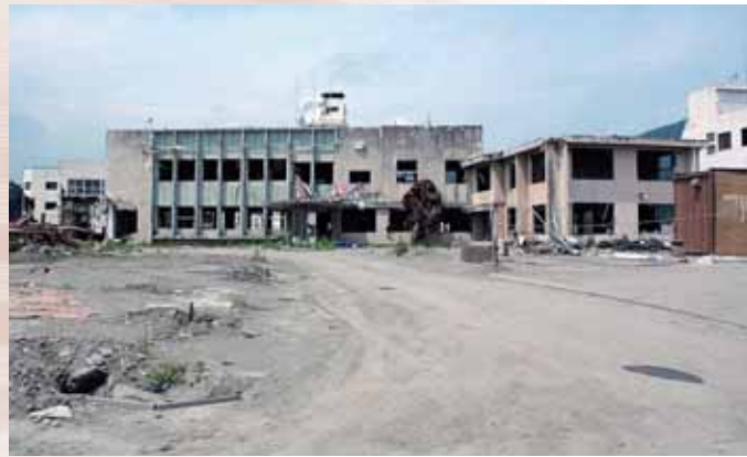
津波で破壊された大槌町役場の様子
